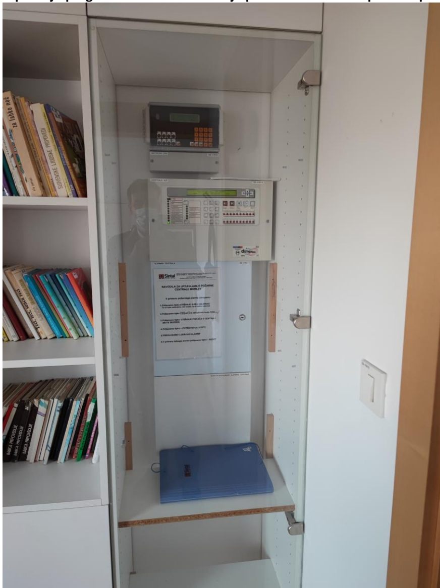
Slika 3: Lokacija obstoječe požarne centrale z matično el. uro ter protivlomno centralo – oisarna v nadstropju.
