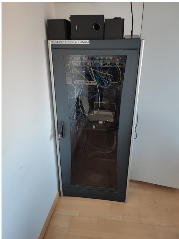
Slika : Komunikacijsko vozlišče, z ozvočenjem v pisarni nadstropja.
