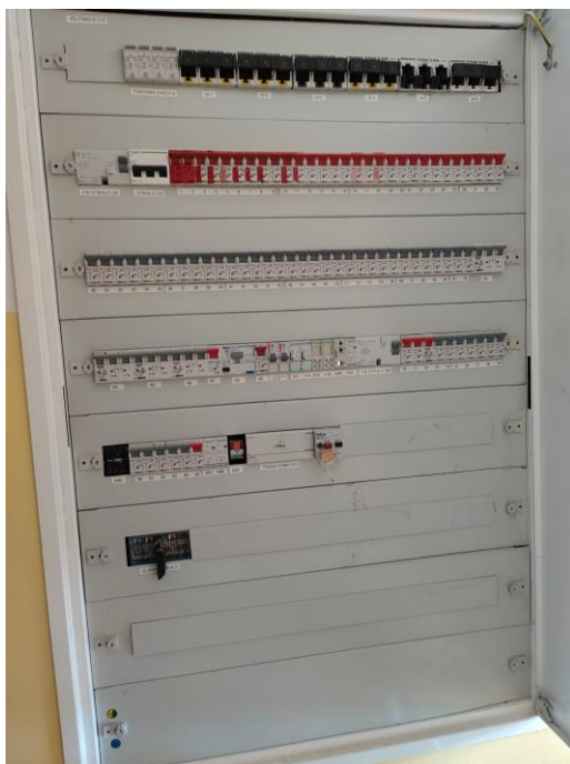
Slika 1 in 2: izgled ter notranjost obstoječega glavnega el. razdelilca SB-V
